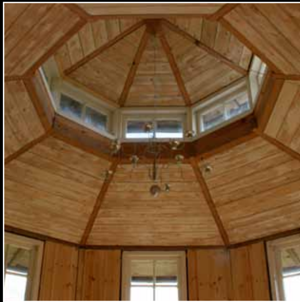
Væg- og loftsbeklædning monteret - i konstruktionen er monteret en krog for ophæng af lysestage
