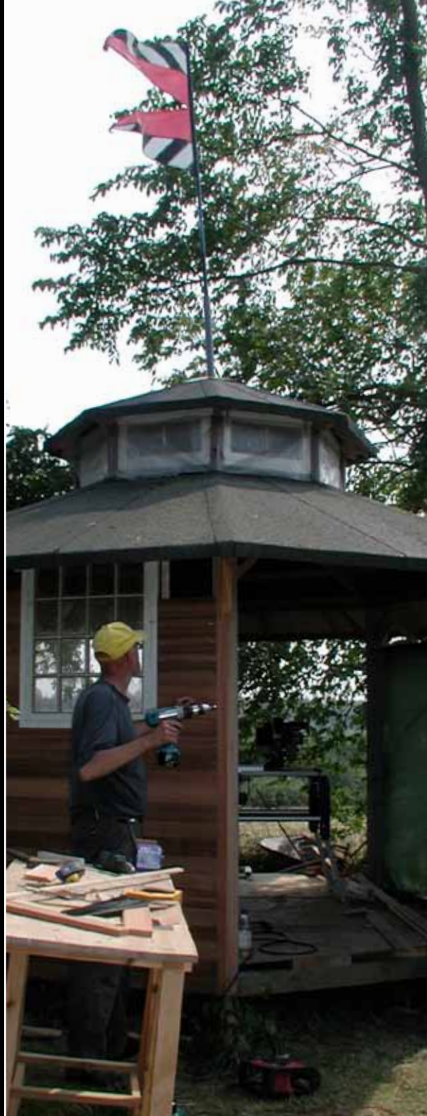
Isætning af vinduer og mon- tering af træbe- klædning
