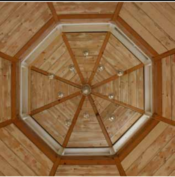
Loftsbeklædning af genbrugsbrædder set i frøperspektiv. Brædderne er fra en nedrivning på Knudebro, Bjergby, Mors. Disse er formentlig fra omkring 1958 da det nedrevne hus stod for en renovering. Ti-armet lysestage hængt fra midten af loftskonstruktion
