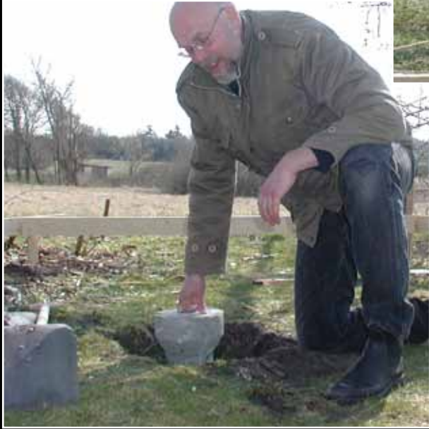
Placering af punktfundamenter
