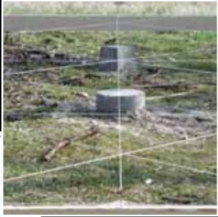
Placering af punktfundamenter
