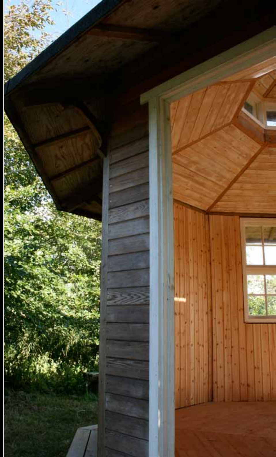
Indvendig beklædning færdigt. De første måltider er indtaget i huset med udkig til mark og mose
